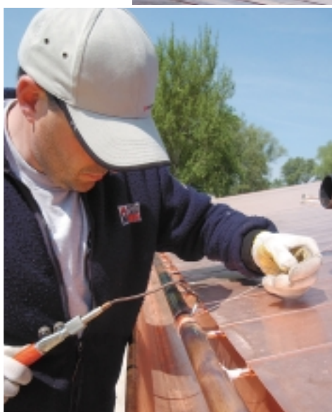
Das System erlaubt dem Dachdecker und Spengler beim Einbau eine hohe Eigenleistung.
