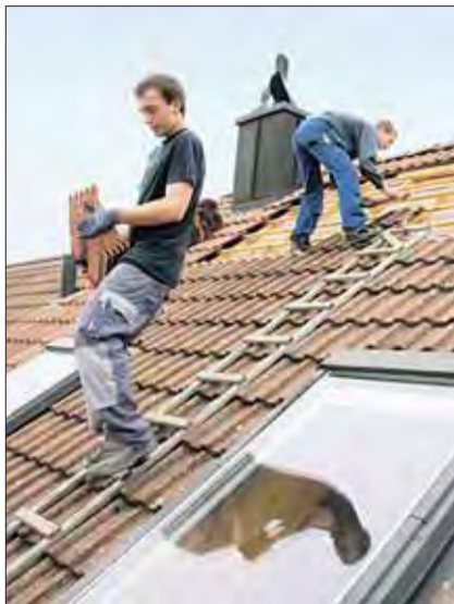
13.00 Uhr: Das Dach wird freigestellt, um die Befestigungslatten zu montieren.
