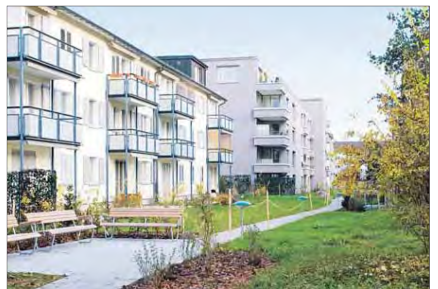
Mit dem Energho-Abo konnte die GEWOBAG die Energiekosten dieser Siedlung in Zürich-Albisrieden bereits im ersten Jahr um 25 Prozent reduzieren – ohne eigentliche Investitionen.
