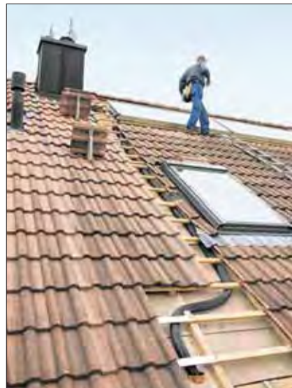
15.15 Uhr: Die Leitung wird fachmännisch verlegt.
