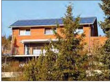
... über die grosszügige Sonnenenergienutzung...
